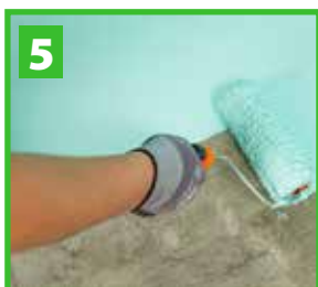
5 Applicera 553 Multiseal Membrane flödigt över hela golvytan inklusive manchett. Åtgång min. 500 g/m 2 .
