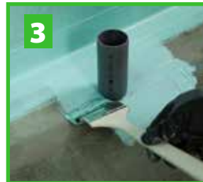
3 Applicera 553 Multiseal Membrane runt avloppsrör.
