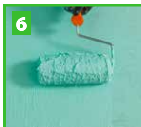
6 När första skiktet är fingertorr appliceras andra skiktet vinkelrätt över det första skiktet. Åtgång min. 500 g/m 2 . Total åtgång min. 1000 g/m 2 .
