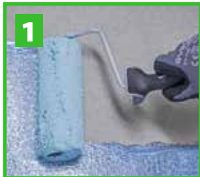
1 Ytan förses med 2x200 g/m 2 555 Vapour Barrier.
