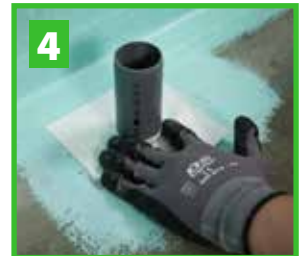
4 Välj manchett efter rörets diameter och tryck fast mot rör och underlag. Täck manchetten med 553 Multiseal Membrane.
