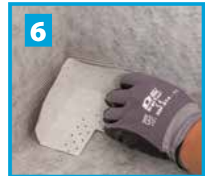
Inner- och ytterhörn monteras i 570 Seal Glue ovanpå 550 Waterproofing Mat 1. Tryck fast ordentligt så att inga blåsor förekommer.
