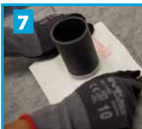
Rörmanschett monteras i 570 Seal Glue ovan på 550 Waterproofing Mat 1. Kamma ut lim (570) 15 mm ut på röret innan montering av rörmanschett.
