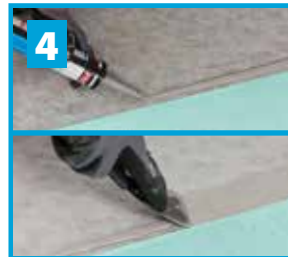
Dukens överlapp limmas med 570 Seal Glue förlöpande under monteringen eller efter att folien har torkat i 553 Multiseal Membrane/560 Vapour Component Glue /580 2K Membrane. Följ anvisning på patronen.
