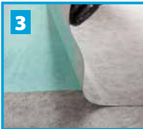
Håll de yttersta 3 cm på båda dukarna/våderna fria från membran (553, 580) eller lim (560). Åtgång: Se ruta 3 – vägg.
