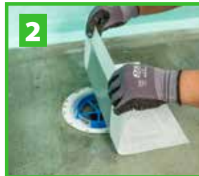
2 Vid golvbrunn monteras självhäftande brunsmanschett (530). Se sid 14.
